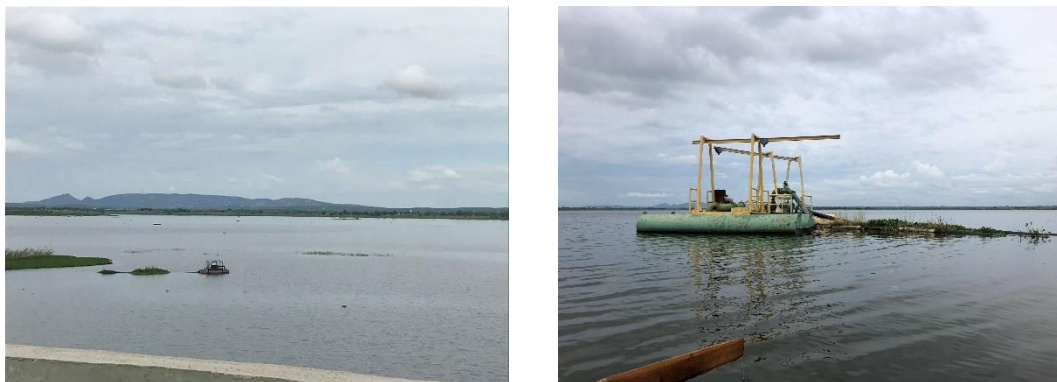
Figura 30 - Captação de Água Bruta - Açude Lima Campos.
