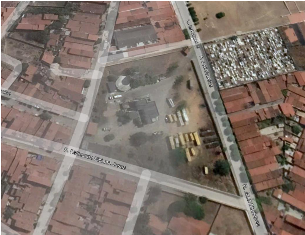
Figura 34 - Vista aérea da ETA da Sede Municipal de Icó (CE).
